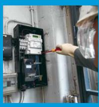
Un compteur intelligent est un compteur électronique qui mesure à a fois l'énergie prélevée et l'énergie injectée dans le réseau et qui communique ses index à une base de données située chez l'opérateur de réseau de distribution. Il offre également d'autres fonctionnalités, comme l'ouverture et la fermeture du compteur à distance. Il permet de connaître rapidement les index exacts, ce qui présente des avantages concrets par exemple en cas de déménagement.
